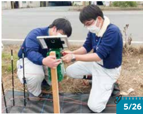
▲圃場の周囲に電気柵を設置する職員
